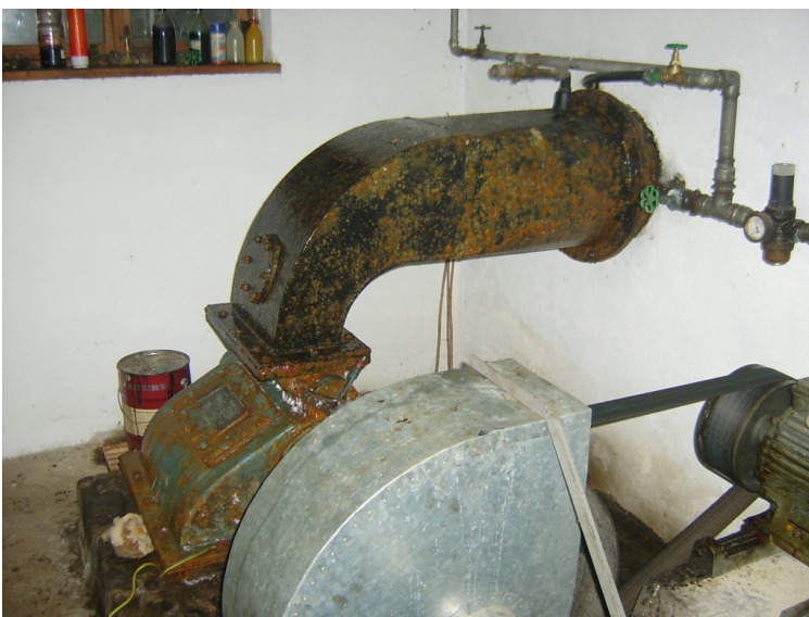
Bild Bestandsturbine, IB Ederer
